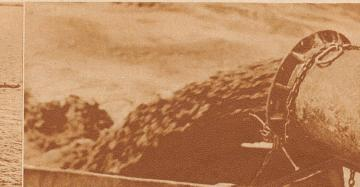
Was dieses Rohr entsteckt, ist nicht Wasser, sondern Schlamm. Durch mächtige Sauger wurde der Schlammstrand dem Meeressoden entzogen und diente dann zum weiteren Aufbau des Damms.
