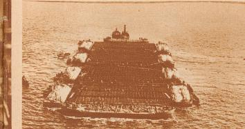
Als Grundlage für den Damm wurden sogenannte „Sink-stücke“ angefertigt. Sie sind aus mehreren Faschenanlagen zusammengetragen, 100-120 Meter lang, 30 Meter breit; sie wurden mit Steinen belastet und dann an der beabsichtig-ten Dammlinie versenkt.
