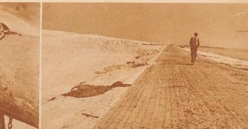
An der Krone muß der Damm 90 Meter in der Breite. Auf dem Damm wird eine Autstraße, ein Weg für Fußgänger und ein Fahrradweg laufen. Später soll noch eine doppelspurige Eisenbahn über den Damm gebaut werden. Eine Fahrt über den Damm vermittelte ganz phantastische Eindrücke. Der getrocknete Sand wirkte in der Sonne weiß wie Schnee.
