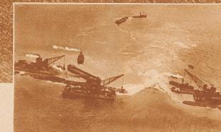
Der Dammöffnung einen Tag vor dem Abschluß. Immer näher schließen sich die beiden Dammenden zusammen. Zwei große, auf Ponton montierte Greifbagger nehmen Sand und Schlamm vom Meeresgrund und schütten das Material in die Lücke. Sonntag den 29. Mai, mittags 1 Uhr, war die letzte Öffnung geschlossen.
