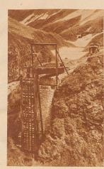
Wie die alljährliche Montage der Steffenbach-brücke vor sich geht: Der östliche Seitenteil mit dem niederhängenden Mittelstück, auf dem man das Geleise und die Zahnradspur erkennt, wird über den Brückenkopf vor-geschoben
