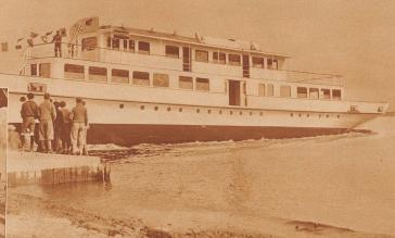
Das Motorschiff «Thurgau» gleitet von der Werft ins Schwäbische Meer. Das Schiff ist 44 m lang, 4 Stockwerke hoch, besitzt einen Tiefgang von 1,47 m, eine Wasserverdrängung von 222 Tonnen und kann 450 Personen fassen
