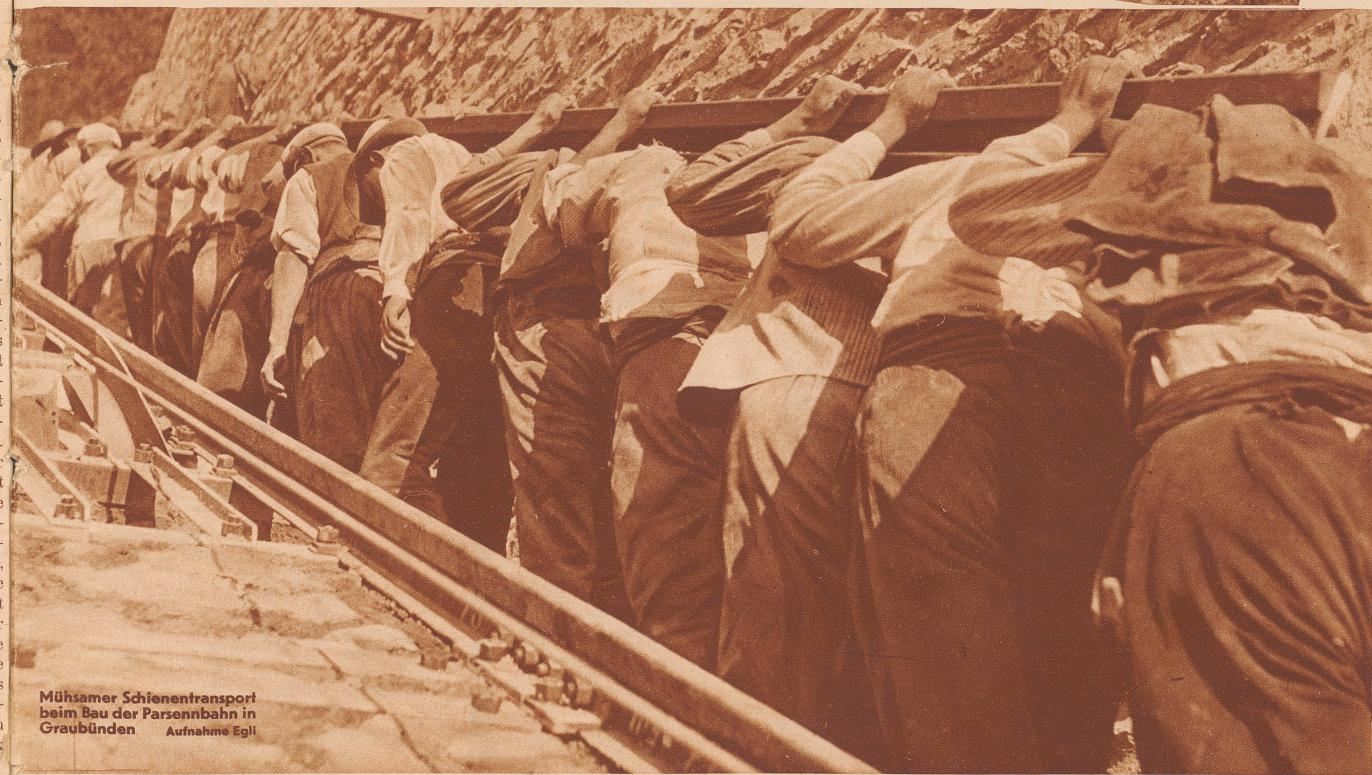
Mühsamer Schienentransport beim Bau der Puschinenbahn in Graubünden Aufnahme Egli
