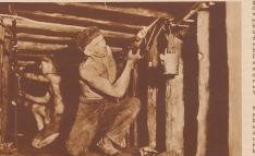
Bild links: Die Rettungs-mannschaft bei der Ar-beit, die unter den schwierigsten Umstän-den bei einer Tempera-tur von 30 Grad mit fieberhafter Schnellig-keit vor sich gehen mußte. – Unser Bild zeigt Verzimmerungs-arbeiten an der neuen Strecke, die parallel zu der zusammengebro-
