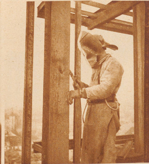
Schweißer mit der Blendhaube bei der Arbeit am Stahlskelett
