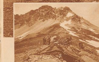
Bild links: Unteroffizierposten am Scherzjoch. Die nach der Zeltzeit überholte Einzellebene bildet wiederlang das Wohnquartier der Soldaten. An Stelle eines Schützengrabens wurde da aus Steinen und Erdschollen eine «Letzimauer» erstellt
