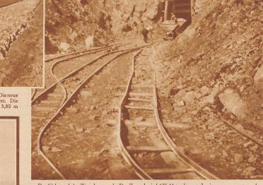
Das Südportal des Zingelentunnels. Der Tunnel wird 175 Meter lang, teilweise ausgemauert, und nach der Fertigstellung elektrisch beleuchtet
