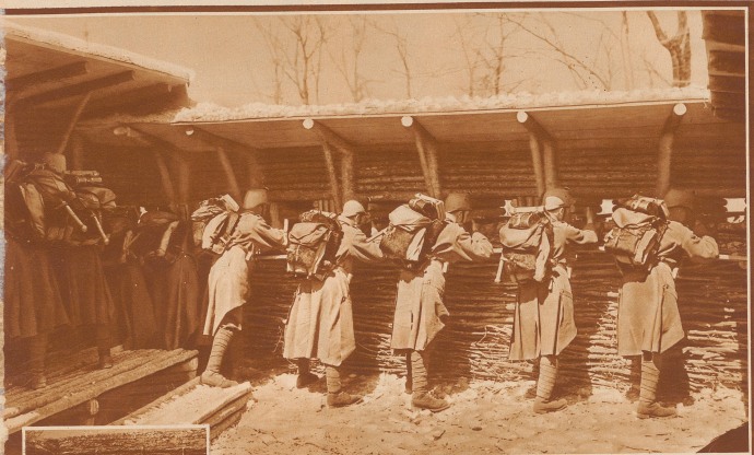
Schlüsselsche Feuerstellung für die Infanterie. Die solide Arbeit unserer Soldaten folgte diesen selbst ein Gefühl großer Sicherheit ein. Gewehr und Maschinengewehrfeuer konnten einem solchen Unterstand wenig schaden, erst nach gründlicher Beschädigung durch die Artillerie wäre es möglich gewesen, in diese Stützpunkte einzubrechen.
