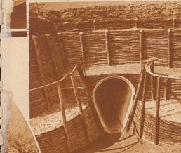
Eingang zu einem unzutreffenden Stollenbau in einem Jurafelsengewerk. Teils in Fleckwerk ausgeführt, teils solid betoniert, und für den Wasserdruck entsprechend verstärkt, war er ein sicherer Unterschlupf. Gegenüber zu den oft schlammgefüllten Laufgräben. Wie für Jahrzehnte nicht mehr zuvor standen Soldaten, aber hier, wo das alles sehr ziemlich verfallen
