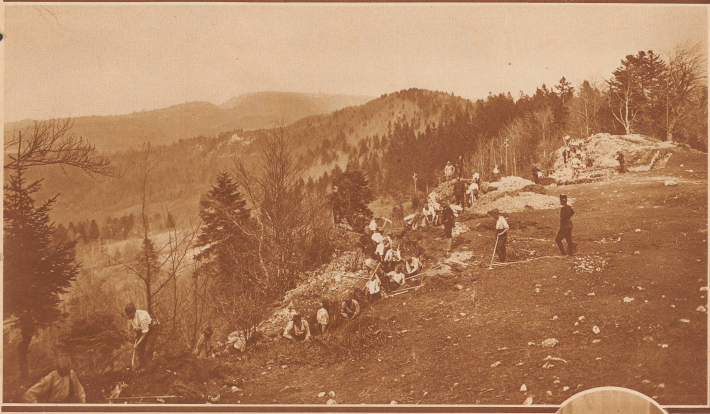
In harter Arbeit wurde von den vorgeschobenen Truppen der Grenze entlang ein ununterbrochener Gürtel von Schlützgräben, Unterständen, Artilleriewerken hergestellt und umgeben. Die erste Linie wurde am 1. August 1914 durch die ersten Einheiten der Schweizer Armee in unserem Lande gezogen. Diese Verteidigungsanlagen, obwohl zum Teil in den letzten Jahren, hauptsächlich im Sommer, sind heute größtenteils zerstört. - Bild: Infanterie beim Gräbenbau auf den Höhen von Les Raux, dem wichtigsten Übergangspunkt vom Delberger Tal über den Jura in die Ajoie
