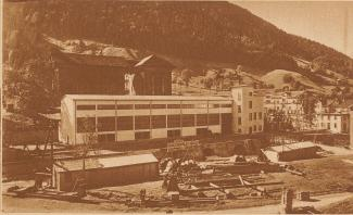
Die Zentrale des Kraftwerkes Sernf-Niederen bach in Schwanden mit daranstoßender Freiluftanlage. Die lichtdurchfluteten Maschinenräume beherbergen vier Turbinen von zusammen 3700 PS. Zwei Mann Belegschaft genügen für die Bedienung der ganzen Anlage
