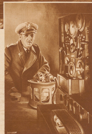
Empfänger (rechts) mit Steuerkreisel (Mitte) eines ferngesteuerten Schiffes
