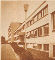
Fassadenteilsansicht der neuen Bibliothek an der Bernerstrasse
