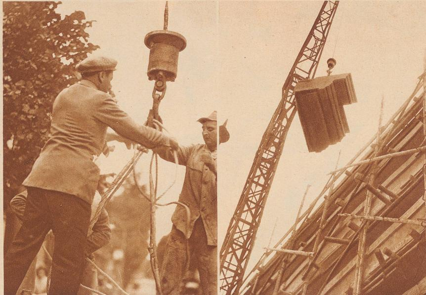
Da sieht man, in die zwei Löcher, die der Steinhauer gemacht hat, haben sie Eisenstangen gesteckt, die mit einem Eisenring versehen sind und die Bauleute Glocken nennen. Sie sind so geschaffen, daß sie nicht aus dem Stein reißen können, wenn der Stein in die Luft schwebt. Und nun wird das Drahtseil des Kranen am Steinblock befestigt. Achtung, Nicki, komm wir gehen etwas auf die Seite.
