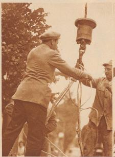
Da sieht man, in die zwei Löcher, die der Steinhauer gemacht hat, haben sie Eisenstangen gesteckt, die mit einem Eisenring versehen sind und die die Bauleute Glocken nennen. Sie sind so geschaffen, daß sie nicht aus dem Stein reißen können, wenn der Stein in der Luft schwebt. Und nun wird das Drahtseil des Kranen am Steinblock befestigt. Achtung, Nicki, komm wir gehen etwas auf die Seite.
