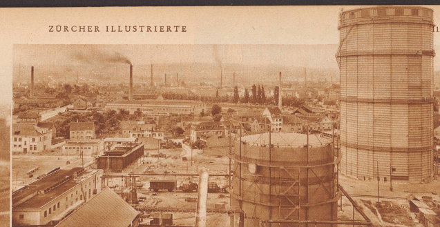
Neben dem mächtigen Gasbehälter von 50 000 Kubikmeter Inhalt steht ein Wasserstoffbehälter mit 10 000 Kubikmeter Inhalt, während jenseits des Rheins die beiden Gasometer der alten Gasfabrik, die 35 000 und 50 000 Kubikmeter fassen, weiterhin ihren Dienst tun.
