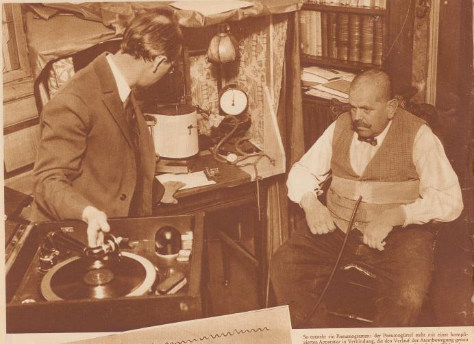
So entsteht ein Pneumogramm: der Pneumogürtel steht mit einer komplizierten Apparatur in Verbindung, die den Verlauf der Atembewegung genau in einer Kurve aufzeichnet. Das Experiment, das wir auf dem Bilde sehen, wurde an einem Handwerksmeister von vorbildlich gesunder, unnervöser Struktur vorgenommen; seine Atmung ergab die ideale, weichgeschwungene Kurve, wie sie sonst im allgemeinen nur im Schlafe hervorgebracht wird; auch als Musik ertönte, veränderte sich das Bild nur unmerklich
