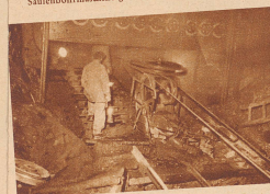
Die Bremsbergstationen bedienen die Hauptförderstrecken im Bergwerk. Die Förderung erfolgt ohne mechanische oder elektrische Zusatzkraft, lediglich durch Gegengewicht und Ladeberggewicht
