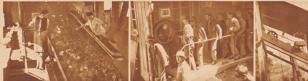
Bei der Entladestation angekommen, wandern die Erze auf ein breites Sortierband, wo Knaben und Mädchen alle Unreinigkeiten, wie Kalk und Schwefel ausklauben und die Erze sortieren
