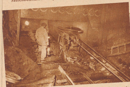
Die Bremsstationen bedienen die Hauptfördererestecken im Bergwerk. Die Förderung erfolgt ohne mechanische oder elektrische Zusatzkraft, lediglich durch Gegengewicht und Ladebergwerk
