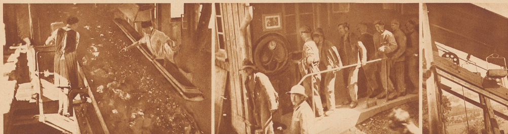
Der Erztransport ins Tal geschah früher in mühsamer und gefährlicher Fahrt auf Holzschlitten durch den Gonzenwald. Nun befördert eine 1400 m lange Luftseilbahn das Erz zur Entladestation beim Bahnhof Sargans
