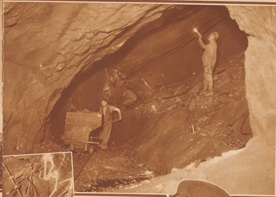
Abbaustelle eines Stollens. Rechts sucht ein Aufseher mit dem Hammer das Gestein nach allfälligen Schäden ab. In der Mitte bohrt ein Miner Löcher für Bodenschürzen, während ein Handlanger das geschossene Erz in die Grubenwagen ladet. Die gefüllten Wagen werden auf den horizontalen Strecken von Hand zur Zentralförderstraße geschoben
