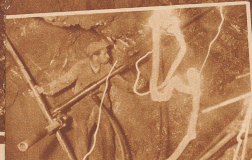
Das Erz wird vom Mineur mit einer 60 kg schweren Sinterbohrmaschine gebohrt und nachher gesprengt
