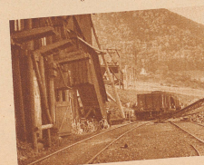
Die Eisenerze werden bei der Entladestation gewaschen und sortiert
