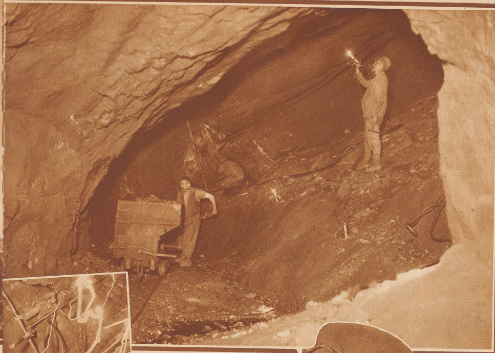
Abbaustelle eines Stollens. Rechts sucht ein Aufseher mit dem Hammer das Gestein nach allfälligen Schloten ab. In der Mitte bohrt ein Mineur Löcher für Bodenschüsse, während ein Handlanger das geschossene Erz in die Grubenwagen ladet. Die gefüllten Wagen werden auf den horizontalen Strecken von Hand zur Zentralförderstrecke geschoben
