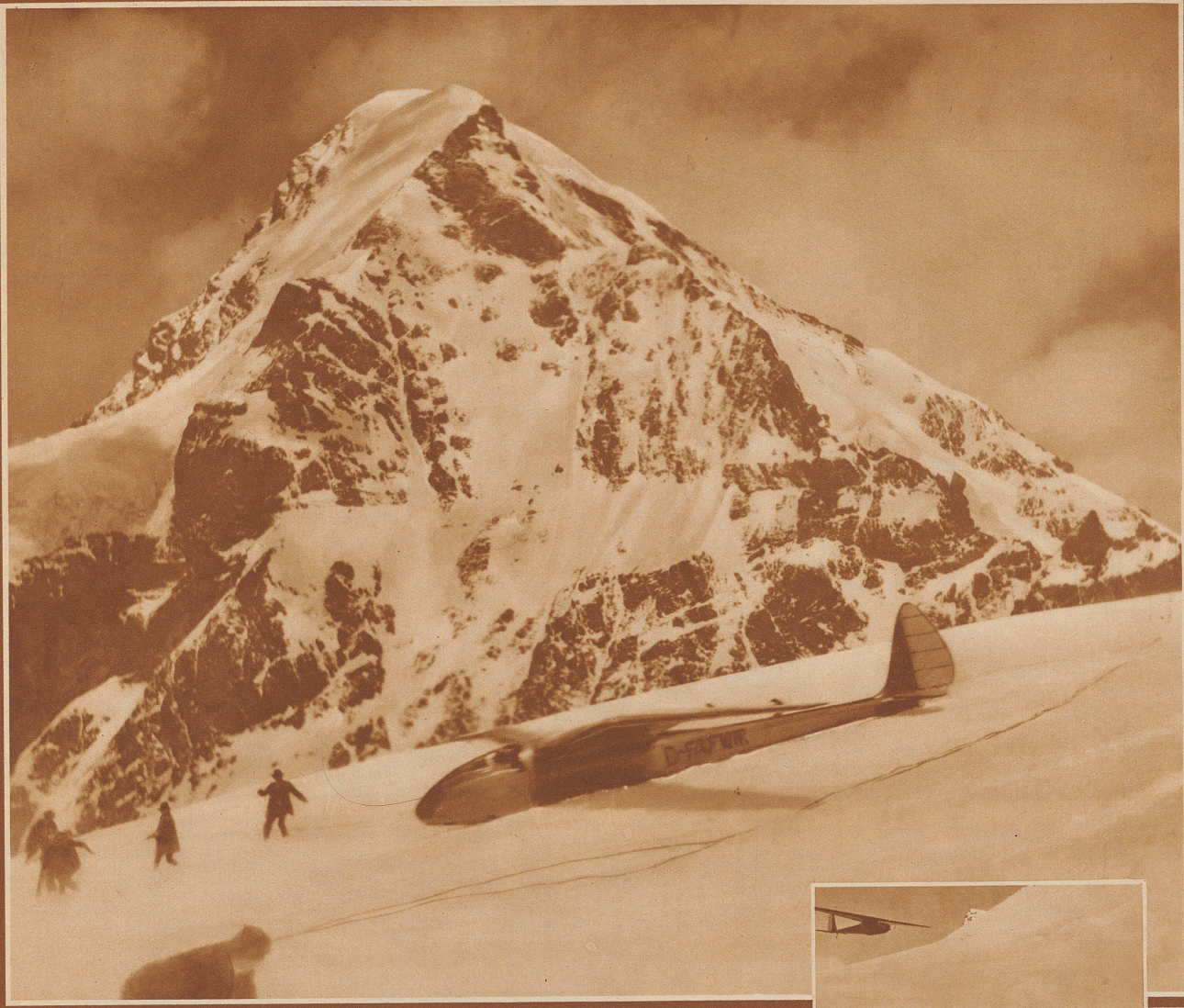
Segelflugzeug beim Start. Damit das Flugzeug starten kann, wird es von der Hilfsmannschaft an langen Tauen über das leichtgeneigte Schneefeld gezogen. Erst wenn es eine gewisse Geschwindigkeit erreicht hat, kann es sich erheben (Phot. Schudel)
