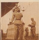
es gelangt die Gondel zur Montage, welche mit den vielen Instrumenten, wie Barometer, Thermometer, Atemometer, Geldrecher und Photoapparaten ausgerützet ist. Die Aufnahme hier zeigt den Korb, der nur zu Fesselballonzwecken benützt wird. Soll der Ballon motorisiert seinen Dienst erfüllen, so wird....
