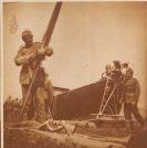
die sogenannte Motorengondel befestigt, die im Besitze eines Leichtmotors zur Eigenbowegung des Lutkshiffs ist. Sie bietet 4 Person genügend Platz. Wie wir sehen, wird der Propeller vor dem Ansetzen noch einer eingehenden Prüfung unterzogen
