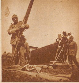
..... die sogenannte Motorgondel befestigt, die im Besitze eines Leichmotors zur Eigenbe- wegung des Luftschiffs ist. Sie bietet 4 Personen genügend Platz. Wie wir sehen, wird der Propeller vor dem Ansetzen noch einer eingehenden Prüfung unterzogen
