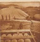
Das Füllen aus den Stahlflaschen benötigt ein Minimum an Zeit. In der Regel ist der 1400 m³ fassende Bällon in 10–20 Minuten startbereit. Unsere Aufnahme zeigt den Stahlflaschenwagen mit der Schlauchleitung zum Ballon
