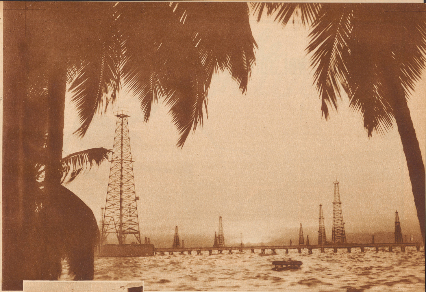
Bohrtürme im Maracaibo-See. Die Palmenhaine und streckenweise der Urwald treten bis an die Ufer des Sees und bilden einen seltsamen Kontrast zu den eisernen Bohrtürmen
