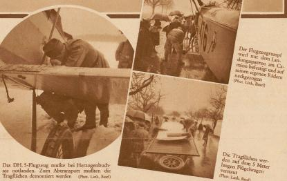
Die Tragflächen wer-den auf dem 5 Meter langen Flügelwagen verstaut (Phot. Link, Basel)
