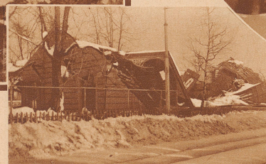
Unter der ungeheuren Schneelast, die sich letzte Woche auf die Dächer legte, brach die Konzerthalle in Neudorf-St. Gallen zusammen (Phot. Saadi)
