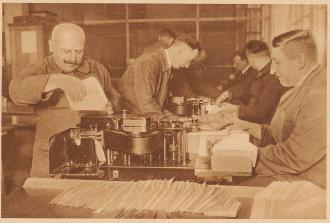
bringt eine moderne Briefschließ- und Stempelmaschine täglich 60 000 Briefe fertig zum Versand. Sie wird von zwei ungelernten Arbeitern bedient
