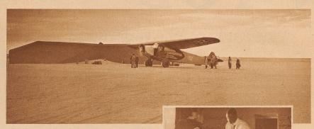
**Reggan.** Hier ist Mittelholzers Maschine durch eine sog. Alveole vor dem Sand der Wüstenwinde geschützt, d. h. es sind Mauern in einem kreuzförmigen Grundriß angeordnet. Hinter den Mauerarmen steht der Apparat geborgen
