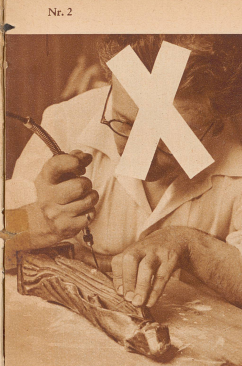
Die Arbeit des Holzwurms verrichtet ein elektrischer Bohrer. In die Löcher werden Wurmlarven und «Wurmmehl» alter Hölzer eingesetzt, um die Täuschung vollkommen zu machen
