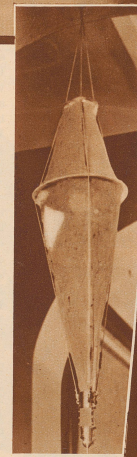
Bild rechts: Kipp-Wasserschöpfer zur Untersuchung des Meerwassers in den verschiedensten Tiefen
