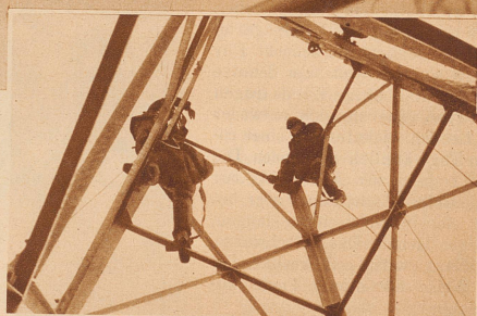
Arbeiter beim Nieten am 125 Meter hohen Funkturm
