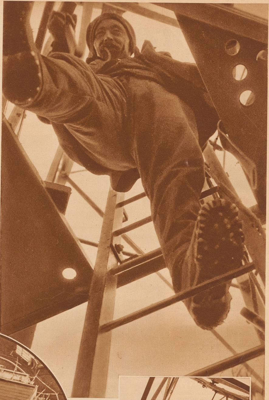
Arbeiter beim Nieten am 125 Meter hohen Funkturm
