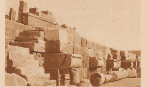
Die aus dem Sand ausgegrabene Hafenmauer. Man sieht die Treppe, die ins Wasser hinabführte, und die Vorsprünge, an denen die Schiffe befestigt wurden
