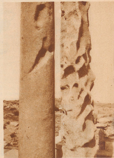
Zwei Säulen, welche über die im Wüstensand versunkene Stadt hinausragen, wurden im Laufe der Jahrtausende durch die Sandstürme auf der Wetterseite gänzlich ausgehöhlt.
