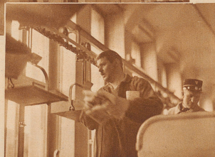
Briefe werden auf die Schaukelförderanlage gelegt
