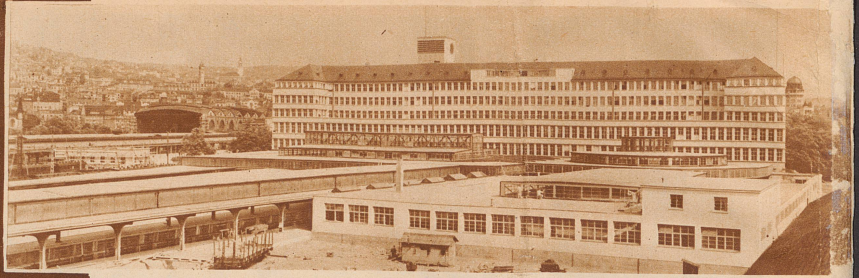
Nordwest-Ansicht der neuen Zürcher Hauptpost mit Garage und Postbahnhof im Vordergrund Phot. H. Wolf-Bender
