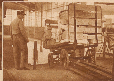
G. Ein vollbepackter Paketwagen wird nicht von Hand gezogen, sondern einfach auf den Kettenförderer gebracht, wo er automatisch einhakt und so durch den Posttunnel in den Bahnhof gelangt
