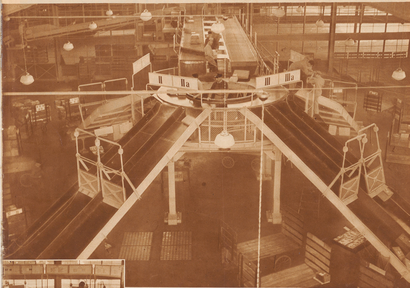
E. Paketversand mit Sortieranlage. Oben auf dem Drehtisch werden die Pakete sortiert und auf die verschiedenen Rutschen abgeschoben
