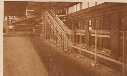
C. Im Postbahnhof. Postwagen stehen zur Leerung bereit. Von den beiden laufenden Bändern, auf die die Pakete gelegt werden, führt das obere in die Ausgabe und das untere in den Versand
