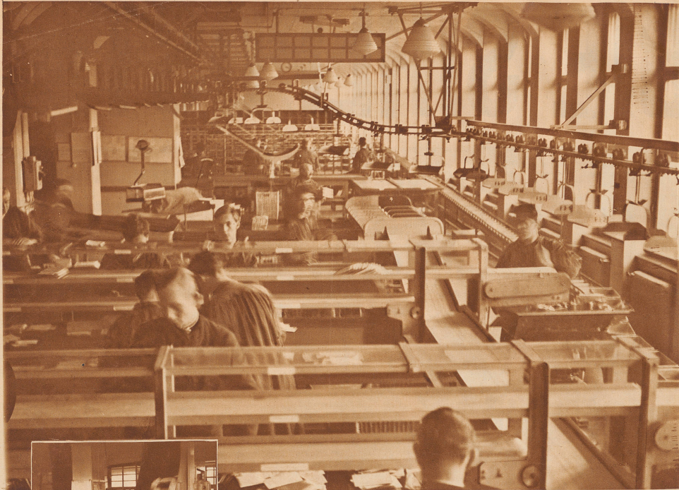
Briefversand. Von den Stellischen im Vordergrund gelangen die Briefe zu den Stempelmaschinen und dann auf der Schaukelförderanlage in die Grobsortierung im Hintergrund. Hier werden jährlich etwa 80 Millionen Briefe und viele Millionen Zeitungen verarbeitet
