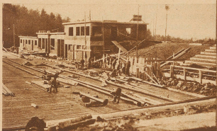
Das Maschinenhaus und die Ankleideräume im Bau
