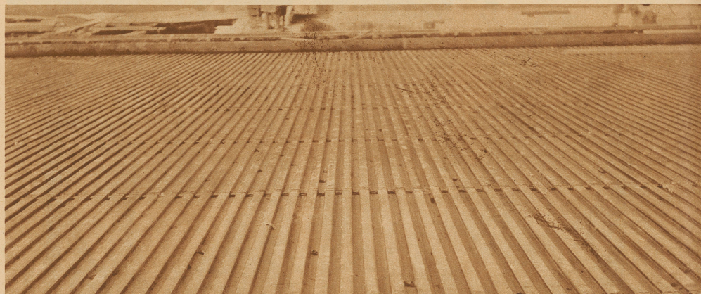
Teilansicht des unter dem Eisfeld liegenden Röhrenrostes. Durch diese 43 000 Meter langen Röhren wird die Kälteflüssigkeit getrieben und so das darüber liegende Wasser zum Gefrieren gebracht
