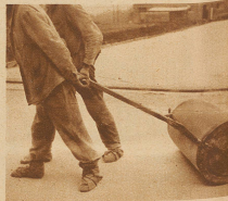
Walzen der Fahrfläche
