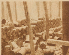
950 Faß Chlor Calcium waren für die erste Füllung nötig
