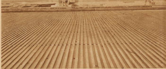
Teilsicht des unter dem Eisfeld liegenden Rohrenwerkes. Durch diese 43 000 Meter langen Rohren wird die Kälteleitfähigkeit getrieben und so das darüber liegende Wasser zum Gefrieren gebracht
