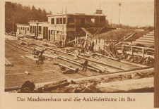
Das Maschinenhaus und die Ankleideräume im Bau
