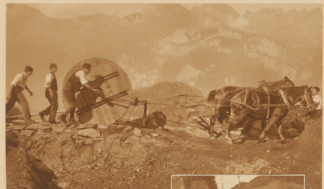
Die Leitungs-Drahtseile, über 1100 Meter lange Teilstücke, sind auf Seiltrommeln oder Bobinen aufgehäpelt. Ihr Transport aus der Talidee in die Berge hinauf ist ein saures Stück Arbeit für Mann und Roß
