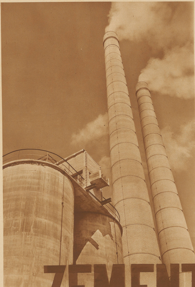
Schlammlos und Hochkamine. Die Silos enthalten das aus Kalk und Mergel gemischte Brenngut
