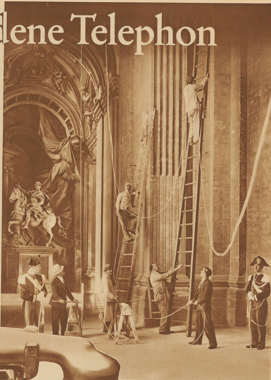
Aufhängen des Kabels im Atrio Carliomagno, der Verbindungshalle zwischen Vatikan und Peterskirche
