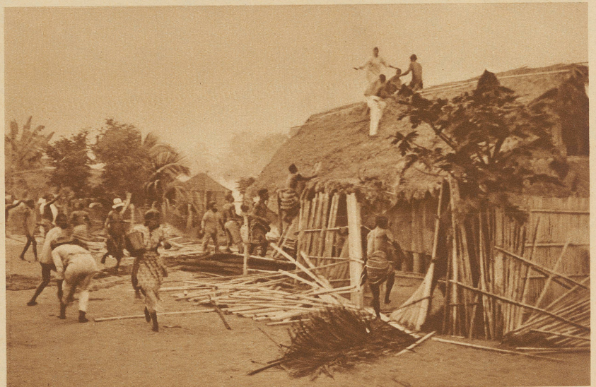
Das Dach einer feuergefährdeten Hütte wird heruntergerissen und die Habseligkeiten werden in Sicherheit gebracht
