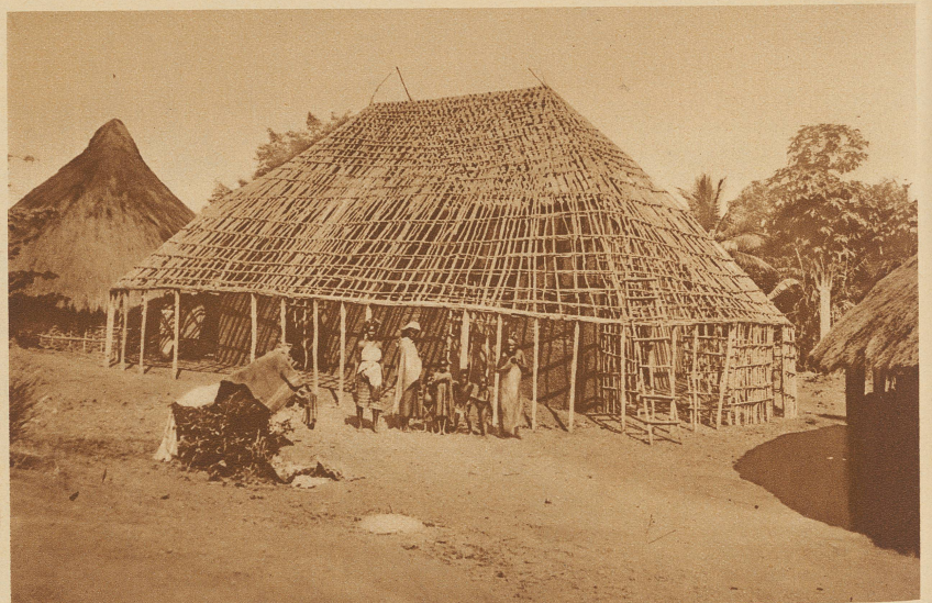
Wiederaufbau: Das Gerüst einer Negerhütte
