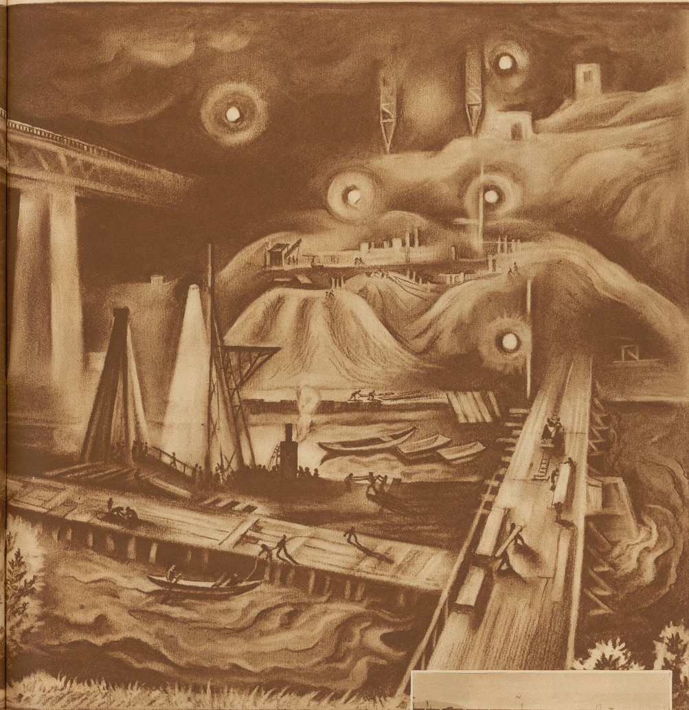
Limmatwerk Wettingen. Die Baustelle für Stauwehr und Maschinenhaus bei Nacht. Zeichnung von H. Markwardt
