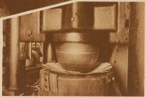
Eine Hälfte der Kugel wird mit einer hydraulischen Presse gepreßt.
