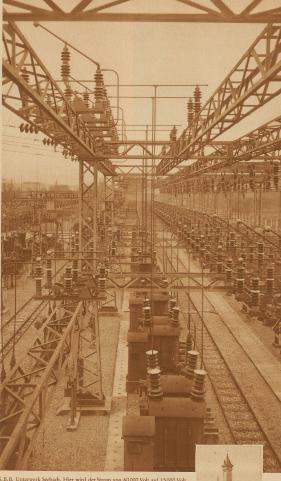
S.B.B. Unterwerk Seebach. Hier wird der Strom von 60000 Volt auf 15000 Volt hinuntertransformiert; erst in dieser Spannung ist er für die Fahrleitung zu gebrauchen (Phot. Stuh)
