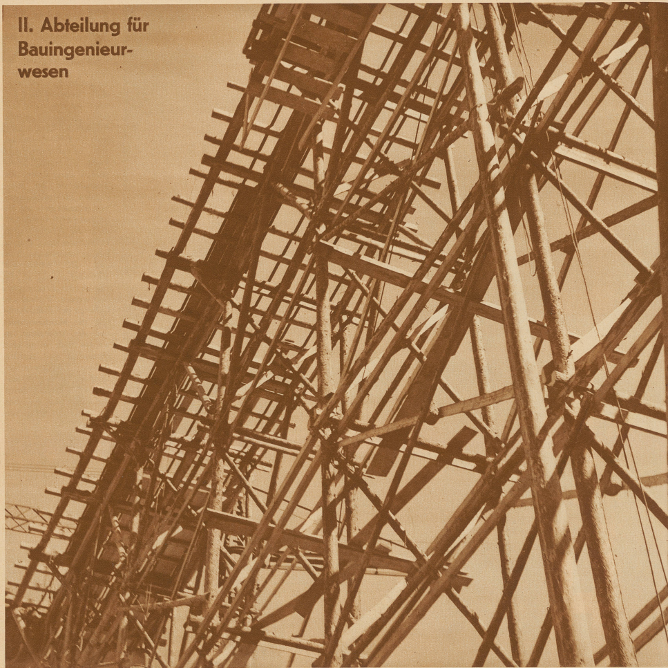
Baugerüst-Konstruktion für die Erstellung der Staumauer am Staubecken Garichte des Niederenbach-Werkes bei Schwanden, Glarus Phot. Menzler
