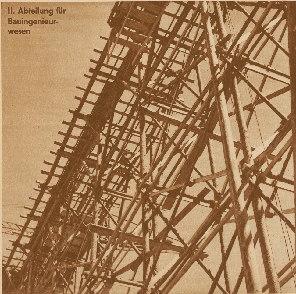
Baugerüst-Konstruktion für die Erstellung der Staumauer am Staubecken Garichte des Niederenbach-Werkes bei Schwanden, Glarus Phot. Meiler
