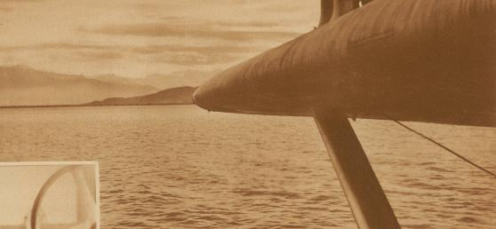
Ueber dem Bodensee. Blick von der Führerkabine auf Tragfläche und Motortürme. Die Mechaniker können auch während des Fluges zu den Motoren gelangen und eventuelle Störungen beheben
