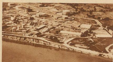
Oeltanks am Magdalenenstrom bei Barranca Vermeja. Diese große Anlage ist durch eine über 600 km lange Rohrleitung mit der Küste verbunden, um den teuren und schwierigen Transport auf Schiffen zu sparen
