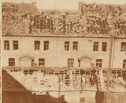
Durch den ungeheuren Luftdruck wurden die Dächer der ganzen Umgebung abgedeckt
