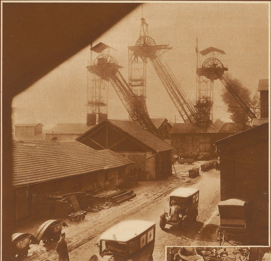
Die Grube Maybach kurz nach der Schlagwetter-Explosion. Der mittlere Turm gehört zum Unglücksschacht, aus dem bei der Explosion meterhohe Stichflammen herausschossen
