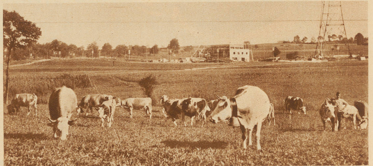
Der neue schweizerische Radio-Landessender im Bau an der Straße Münster-Sursee. Die Antennenmasten werden 120 m hoch. Das Sendehaus ist im Rohbau fertig. Die Eröffnung ist auf nächstes Frühjahr vorgesehen (Phot. Kopp)
