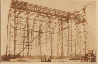
Die größte Luftschiffhalle der Welf mit 900000 Kubikmeter umbautem Raum ist gegenwärtig in Friedrichshafen im Bau begriffen. Sie soll schon im März nächsten Jahres fertig sein und zur Aufnahme des neuen riesigen Zeppelinluftschiffes dienen
