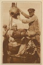
Dem Taucher wird der Helm aufgesetzt und festgeschraubt
