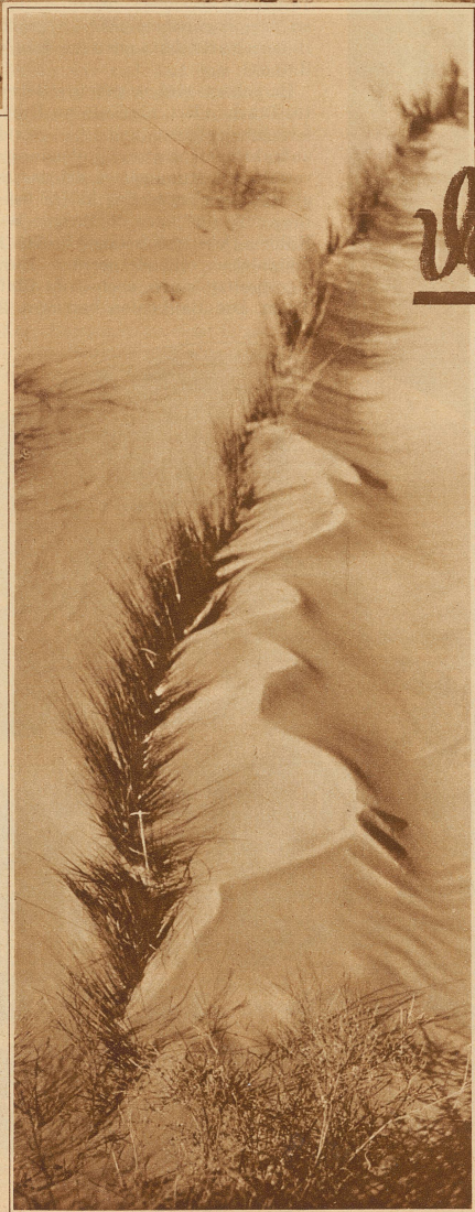
Zwischen Tripolis und Leptis Magna ist man daran gegangen, systematisch Graspalisaden zu errichten, die den wandernden Sand aufhalten und so Verwehungen verhüten sollen
