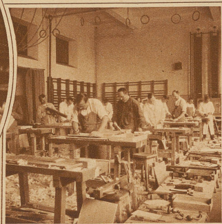
Die Schreinerwerkstatt in der Turnhalle
