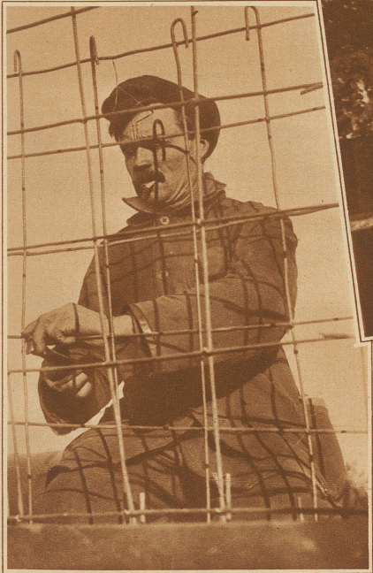
Die Arbeit ist ein Gitter — ein geistiges — denn sie ist da, sie muß getan werden und hemmt des Menschen Drang nach schrankenloser Freiheit. — Dies versinnbildlicht dieser Bauarbeiter an einem Eisenbetonbau
