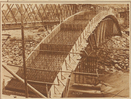
Die neue Brücke kurz vor dem Einsturz. Der flache Bogen hat eine Stützweite von 88 m. Der Gerüstpfiler in der Mitte ist dann zusammengebrochen
