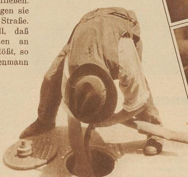
Alle 5 Minuten steigt der Spritzenmann bei einem Hydranten ab, um 1000 Liter Wasser nachzufüllen
