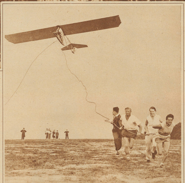
Ein gelungener Start. Die Startmannschaft hat mit der Zugleine den Apparat in die Höhe gerissen
