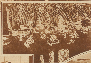
Bild rechts: Das auf dem Wasser schwimmende Holz wird in diesem Sortierwerk nach seinen Benutzungsmöglichkeiten sortiert und in die verschiedenen Abteilungen geleitet
